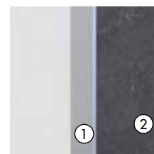
1. Profilo in alluminio 2. Rivestimento stipite
