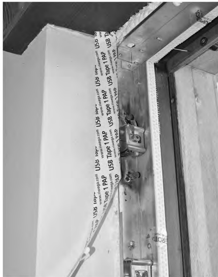
Togliere la vecchia porta, provare il controtelaio nel vano porta, verificare con la livella.
