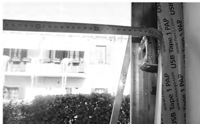
Togliere la vecchia porta, provare il controtelaio nel vano porta, verificare con la livella.
