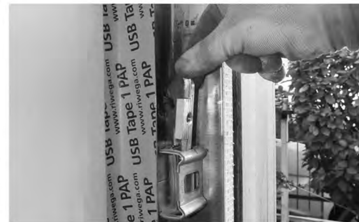
Togliere la vecchia porta, provare il controtelaio nel vano porta, verificare con la livella.
