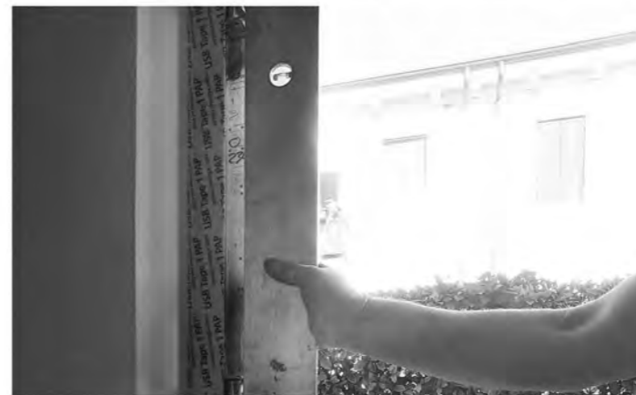
Togliere la vecchia porta, provare il controtelaio nel vano porta, verificare con la livella.
